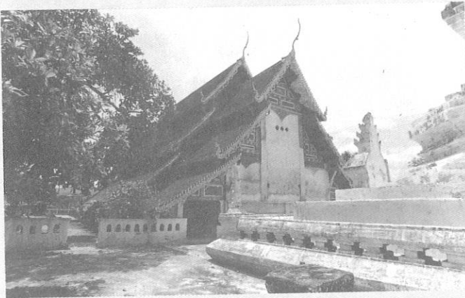
ภาพที่ ๑๘ ด้านหลังวิหารหลวงวัดเวียง เป็นแบบผนังก่อปูนปิดทึบ เปิดช่องทางเข้าออกเฉพาะที่แนวช่องทางใต้ชายคาปีกนกทั้งสองข้าง ระดับพื้นที่ใต้ชายคาปีกนกนี้เป็นระดับเดียวกับพื้นลานวัด ส่วนพื้นภายในส่วนกลางวิหารเป็นแบบยกกระดานสูงชันประมาณ ๕๐ ซม.
