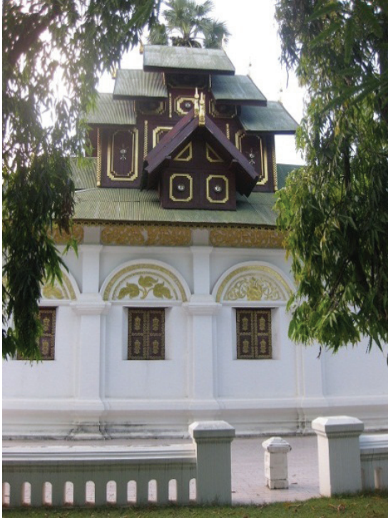
ภาพที่ 3 หลังคาแบบพม่าที่เรียกว่า ยวนตังงาซิน วัดป่าฝาง จังหวัดลำปาง
